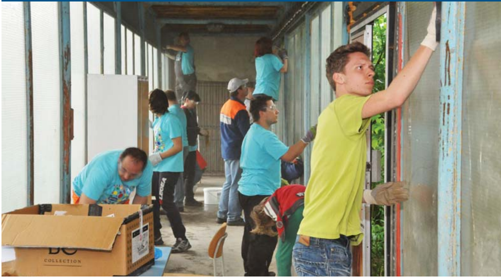
Keď vonku úradoval dážď, pustili sa dobrovoľníci pod strechou do čistenia konštrukcie spojovacej chodby.
